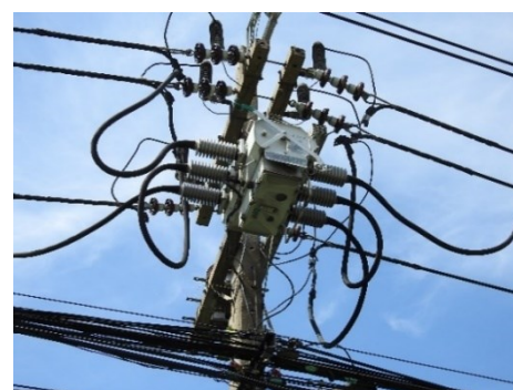
งานติดตั้งคาปาซิเตอร์และสวิตช์ SF6
