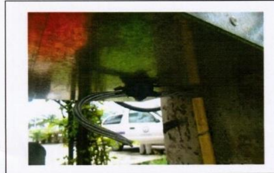
7.การยึด U-Clamp สาย GND.
