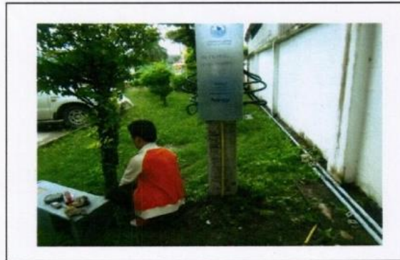
7.การยึด U-Clamp สาย GND.
