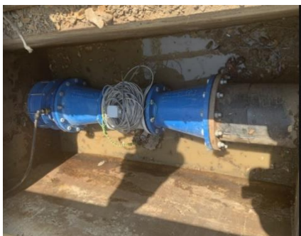
การติดตั้ง RTU
