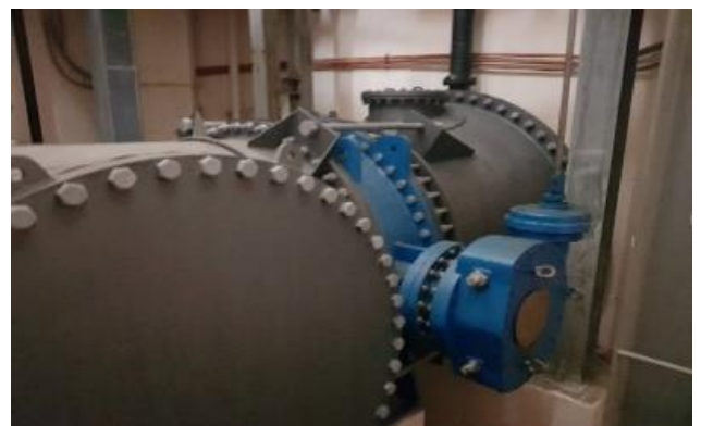
เสริมจุดจ่ายน้ำเพิ่มเติม (Valve Chamber)
