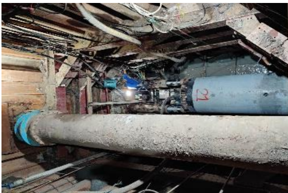
เปลี่ยนและปรับปรุงเส้นท่อประธานที่ชำรุดหมดอายุการใช้งาน
