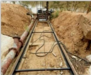
สะพานรับรางเลื่อนเครื่องสูบน้ำแรงต่ำ
