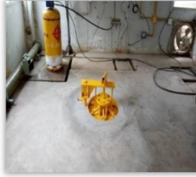
เครื่องจ่ายสารเคมี – เครื่องจ่ายแก๊สคลอรีน
