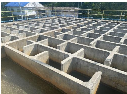
ก่อสร้างบ่อแบ่งน้ำดิบ
