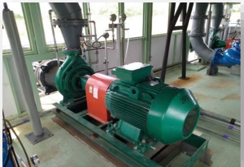
ติดตั้งเครื่องสูบน้ำ
