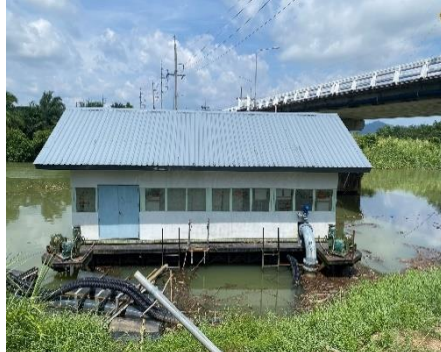
ก่อสร้างโรงสูบน้ำแรงต่ำแบบแพสูบน้ำ
