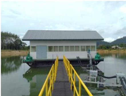
ก่อสร้างโรงสูบน้ำแรงต่ำ แบบแพสูบน้ำ (เล็ก)
