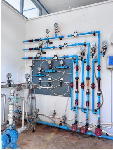
โรงเก็บจ่ายสารเคมี ท่อจ่ายสารเคมี และการติดตั้งเครื่องจ่ายสารเคมี
