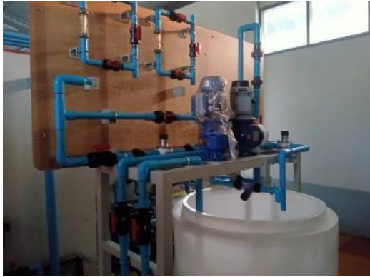
ติดตั้งเครื่องจ่ายสารเคมีและแก๊สคลอรีน
