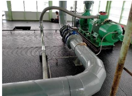
ติดตั้งเครื่องสูบน้ำ
