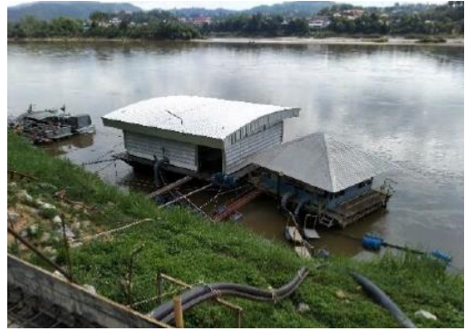
ก่อสร้างแพลอยเล็ก
