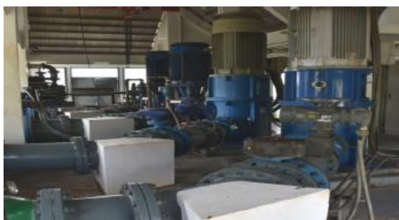
เครื่องสูบน้ำ และท่อส่งน้ำดิบ สถานีสูบน้ำดิบบ้านบัวเทิง
