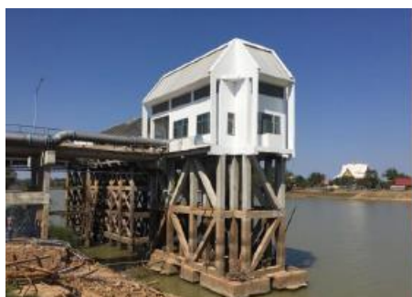
อาคารสูบน้ำ (Turbine) พร้อมระบบอาคารรับน้ำและแนวหินป้องกันตลิ่ง เครื่องสูบน้ำ (แรงต่ำ) และระบบท่อส่งน้ำดิบ สถานีสูบน้ำโพธิ์มูล
