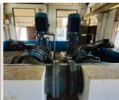
อาคารสูบน้ำ (Turbine) พร้อมระบบอาคารรับน้ำและแนวหินป้องกันตลิ่ง เครื่องสูบน้ำ (แรงต่ำ) และระบบท่อส่งน้ำดิบ สถานีสูบน้ำโพธิ์มูล
