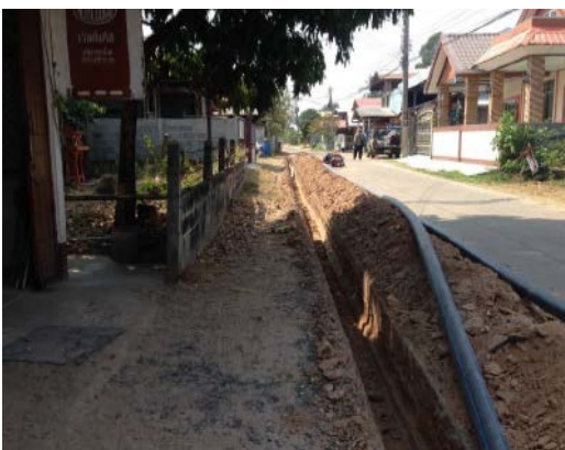
งานวางท่อส่ง – จ่ายน้ำ ขยายเขตระบบประปา โดยการประสานท่อใหม่กับท่อเดิม และซ่อมผิวจราจร
