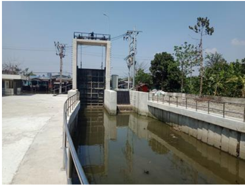
ก่อสร้างระบบป้องกันน้ำท่วม จ.นนทบุรี (กรมโยธาธิการและผังเมือง)
