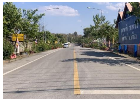
ทล.118-บ.ใหม่แสงแก้ว จ.เชียงราย (กรมทางหลวงชนบท)
