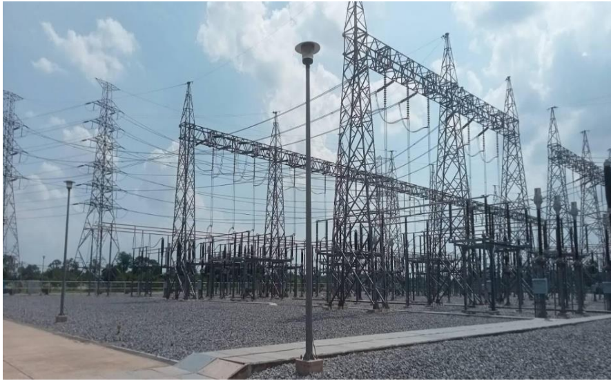
12.6 งานก่อสร้างสายส่งและสถานีไฟฟ้าแรงสูง 230 kV กระบี่ - พังงา 2 - ภูเก็ต 3
