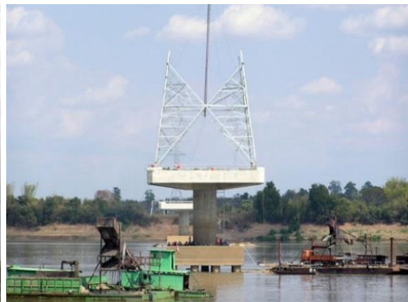
งานติดตั้งเสาโครงเหล็กในแม่น้ำโขง
