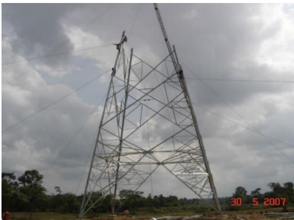
งานติดตั้งเสาโครงเหล็กบนฝั่ง
