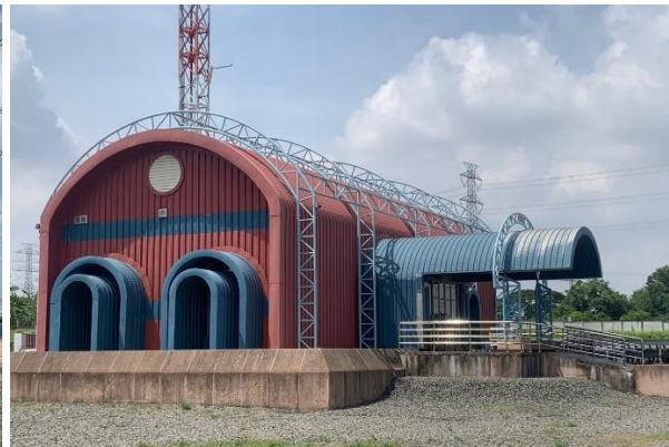
อาคารควบคุมระบบส่งไฟฟ้า (RELAY ROOM)
