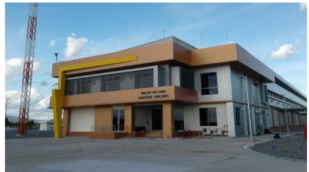
อาคารควบคุม 500 kV GIS
