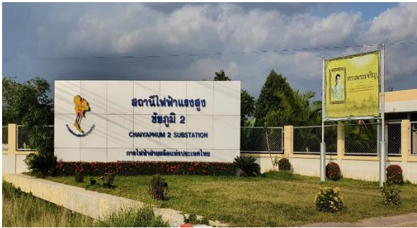
สถานีไฟฟ้าแรงสูงชัยภูมิ 2
